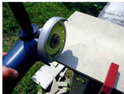
Для резки керамогранита понадобится болгарка с алмазным диском.
