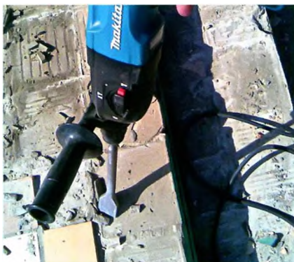
Старые плитки и раствор удаляем, используя перфоратор с насадкой-зубилом.
