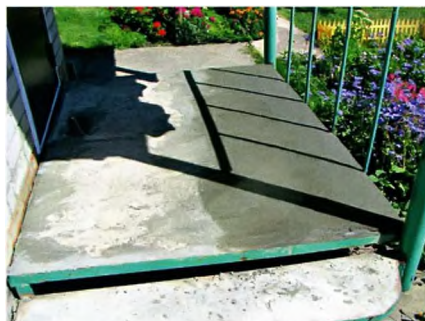
Для дальнейшей работы раствору надо дать застыть.
