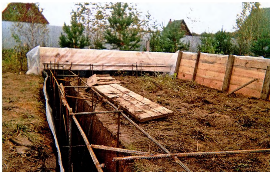
Изготовление щелевого фундамента в плотном неосыпающемся грунте.
