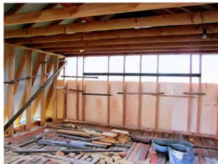
Мансардный этаж: настил пола временный, из старых досок.
