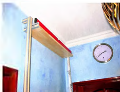
Установленные верхняя и нижняя полки задают ширину стеллажа.
