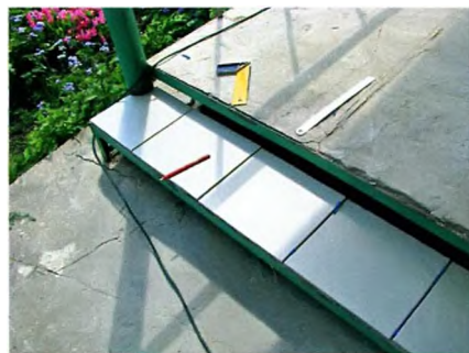
Перед приклеиванием плитки разложим её насухо, выдерживая толщину шва.
