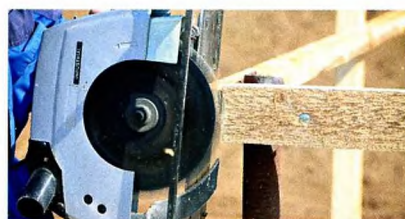
Бруски обвязки крепят к кронштейнам болтами или с помощью шпилек.
