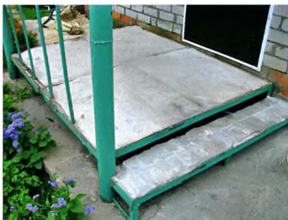
Очищенную поверхность площадки и ступеней требуется выровнять.
