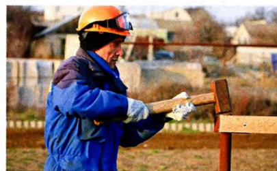
Не стоит сразу топить стойку на всю глубину. Лучше потом, после частичного монтажа каркаса, «подстучать» её кувалдой.
