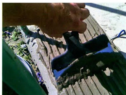
Для нанесения клея используем зубчатый шпатель.
