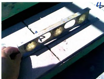
Чтобы выдержать плоскость, положение каждой плитки проверяем уровнем...
