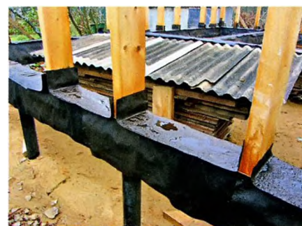
Так закрыт пояс нижней обвязки.
