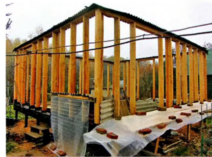
Укрытие каркаса. Плёнка и временный навес закрывают от снега крышку погреба. Справа на верстаке закрыты неиспользованные доски.
