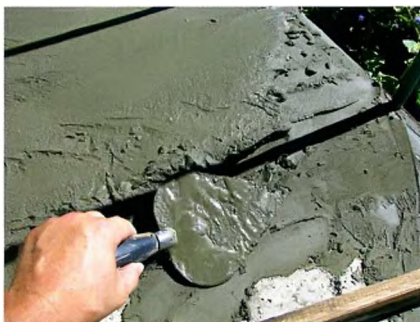
Для выравнивания поверхности используем раствор с добавлением клея ПВА.
