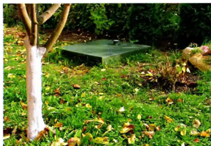
Канализационную станцию установили на краю участка в соответствии с требованиями нормативных документов.
