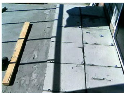
Плитку кладём, начиная от края стены, двигаясь к перилам.
