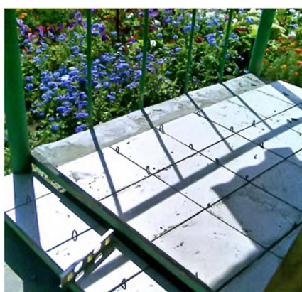
На последнем ряду надо примерить плитки для разметки вырезов под стойки перил.
